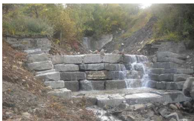
Ricostruzione briglia in massi ciclopici
